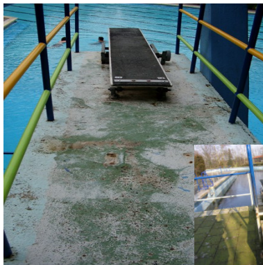
Die Sprungturmanlage wurde für die Saison 2005 mit einem neuen Anstrich versehen. Jedoch besteht auch hier grundsätzlicher Sanierungsbedarf.
